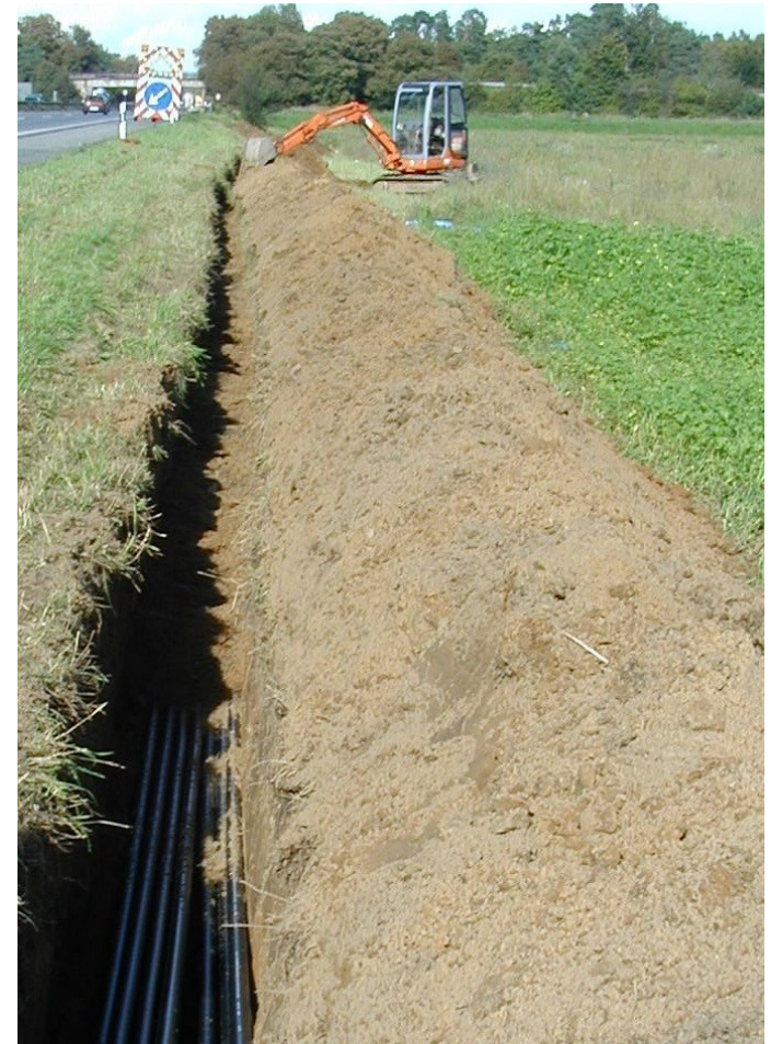
Offener Graben mit Bagger*
